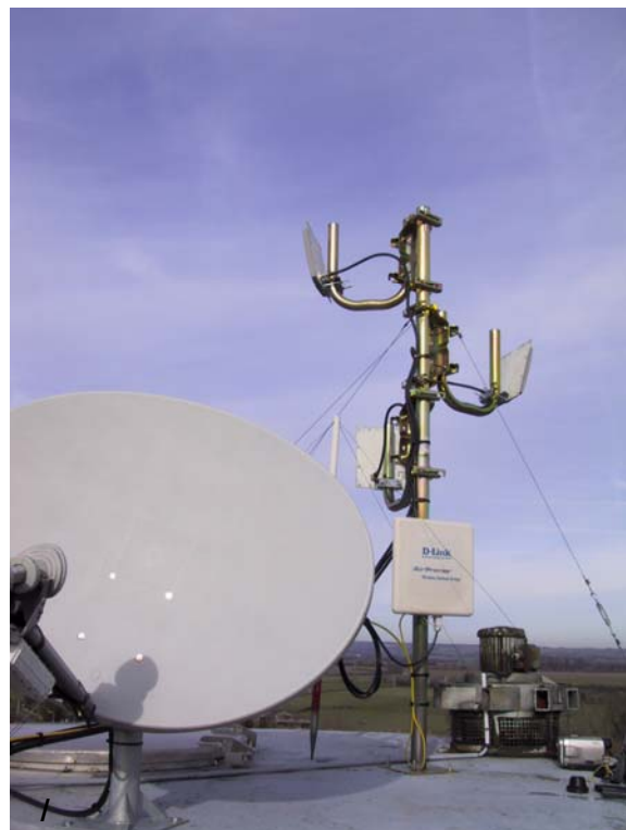
n Installation Satellite et WiFi sur le château d'eau de St Agil (Collines du Perche – Vendômois).
